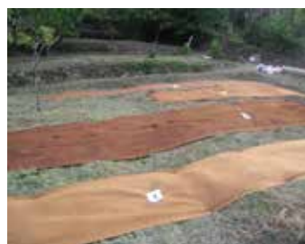
Gronddoek uit geweven en nonwoven jute - La Zéloise (BE)
