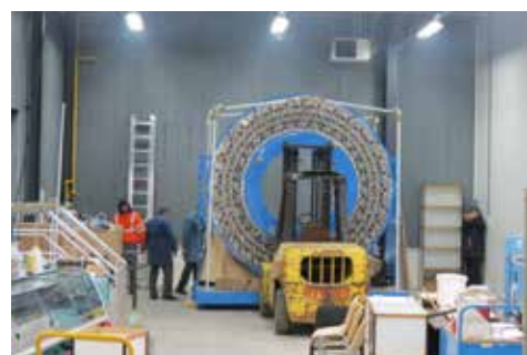
installatie van de vlechtmachine in de nieuwe loods
