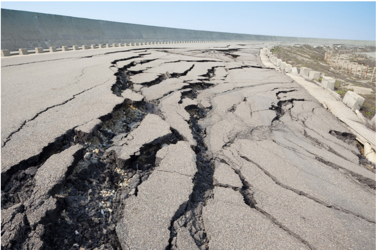
weg vernield door grondverschuiving
